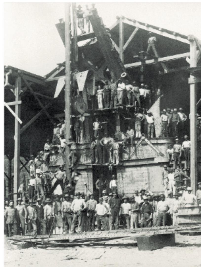
Grupo de trabajadores durante la construcción del canal de Panamá.
